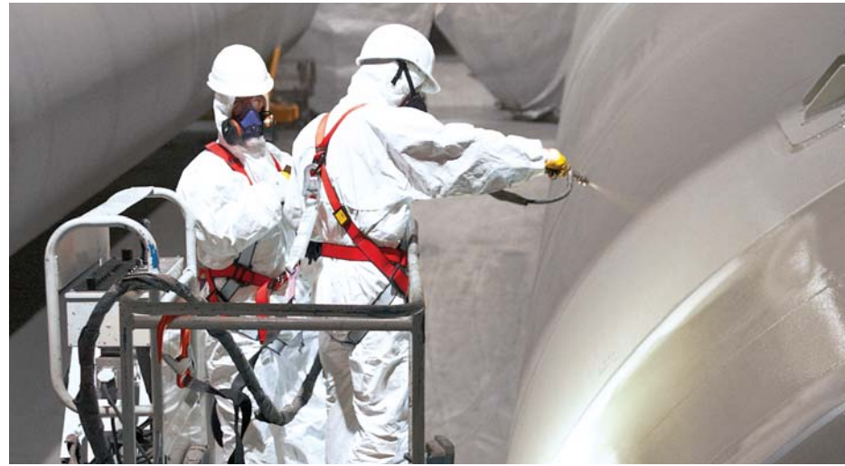
Bei der Heißbeschichtung muß zügig gearbeitet werden, da das Material schnell aushärtet
