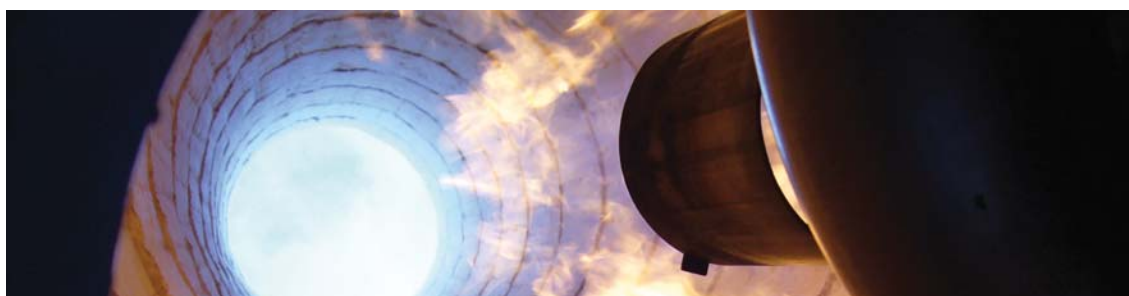
Blick in eine mobile Brennkammer. Eine flexible Lösung zur Abgasbehandlung nach Öffnen eines Fermenters
