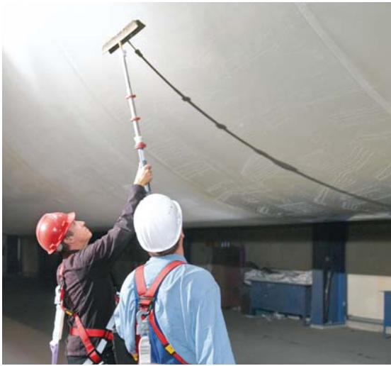
Porenfreie Dichtigkeitsprüfung der fertigen Oberfläche mittels „Abfunken“
